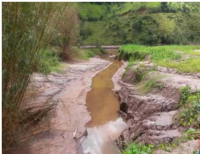
Imagem 203- Vista do TC03 antes das obras de recuperação, taludes com presença de ravinas e escoamento sobre rejeitos.
