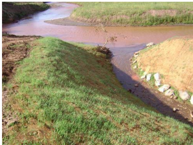
Imagem 302- Situação da foz do TG23 após as obras, remoção dos rejeitos do fundo, conformação e proteção dos taludes.
