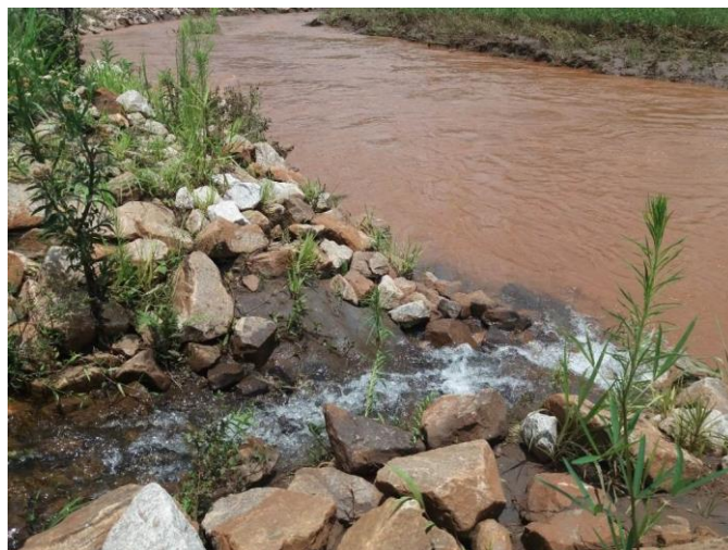
Imagem 20- Foz do tributário TG01A – mostrando proteção das margens e sistema de drenagem.
