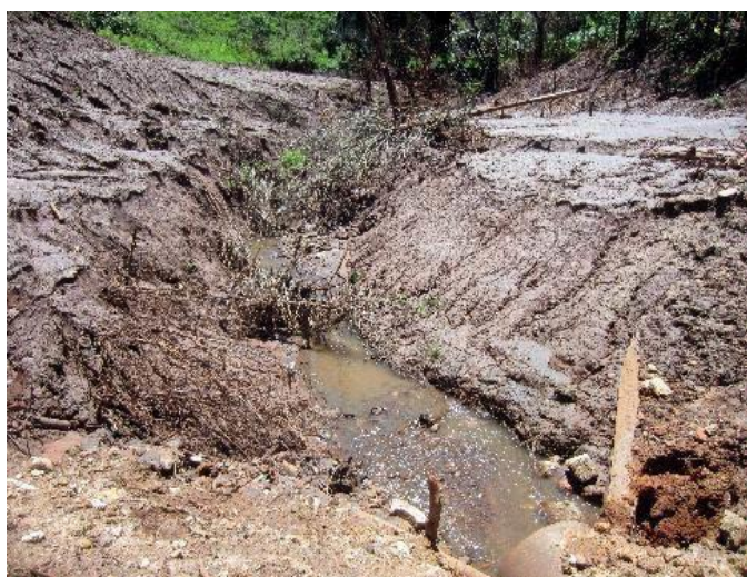
Imagem 139- Vista do TG27 antes das obras de recuperação, presença de ravinas nos taludes.
