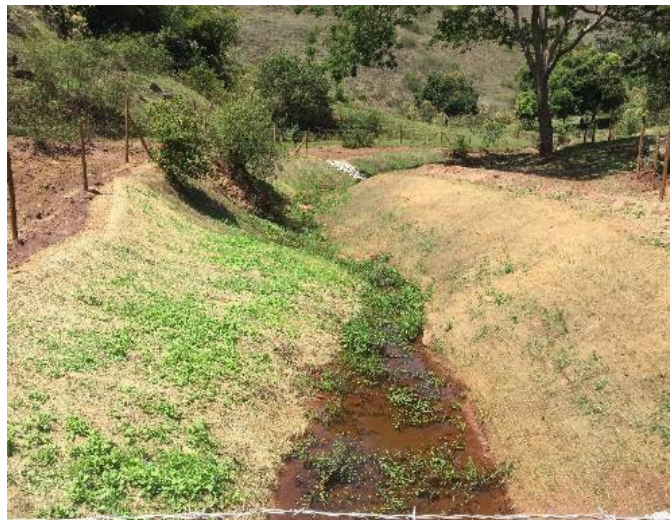
Imagem 176- Vista do TG45 após as obras de recuperação, conformação dos taludes e aplicação de biomanta.
