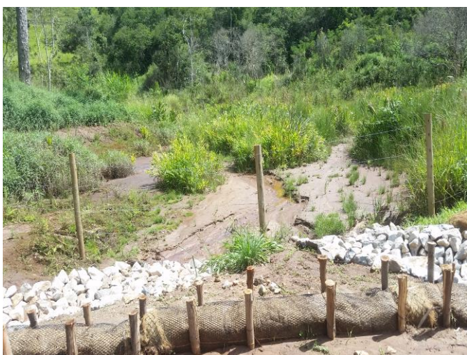
Imagem 299- Serviços de bioengenharia executados no TG37: Enrocamento e aplicação de retentores de sedimentos.
