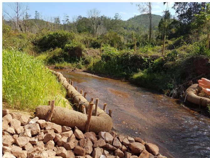
Imagem 306- Obras de bioengenharia executadas no TG14A: Enrocamento, revegetação e aplicação de retentores de sedimentos.
