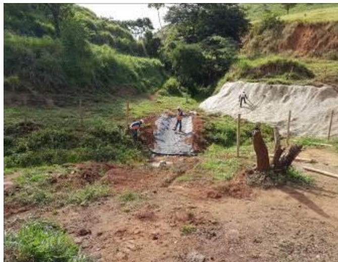
Imagem 180- Obras de bioengenharia sendo executadas no TG47, conformação dos taludes e aplicação de biomanta.
