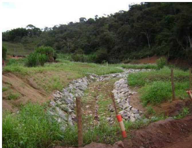
Imagem 160- Situação do TG28 após as obras, remoção dos rejeitos, conformação e proteção dos taludes.
