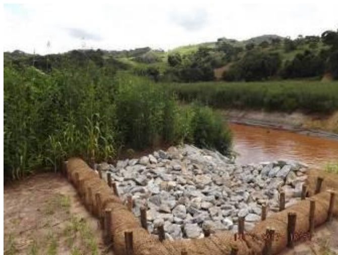
Imagem 122- Descida d'água instalada próxima a foz do tributário TG39.
