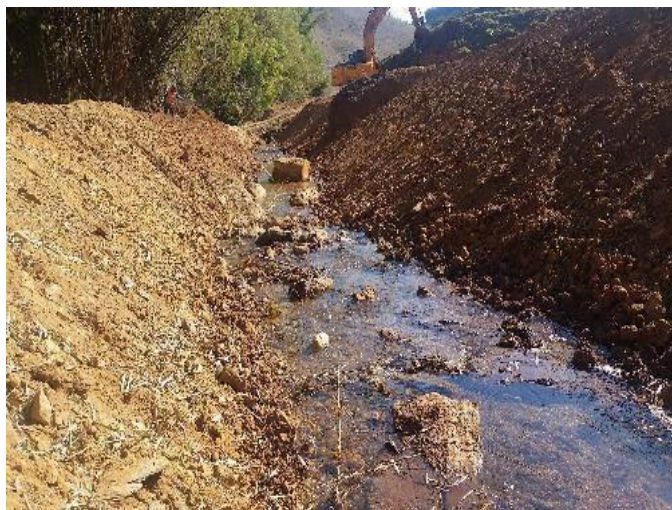
Imagem 357- Vista de jusante para montante do TC08 durante as intervenções, conformação dos taludes.
