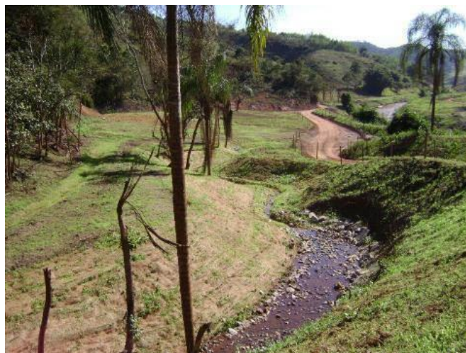
Imagem 126- Situação do TG25 após as obras, conformação e proteção dos taludes, vegetação em crescimento.
