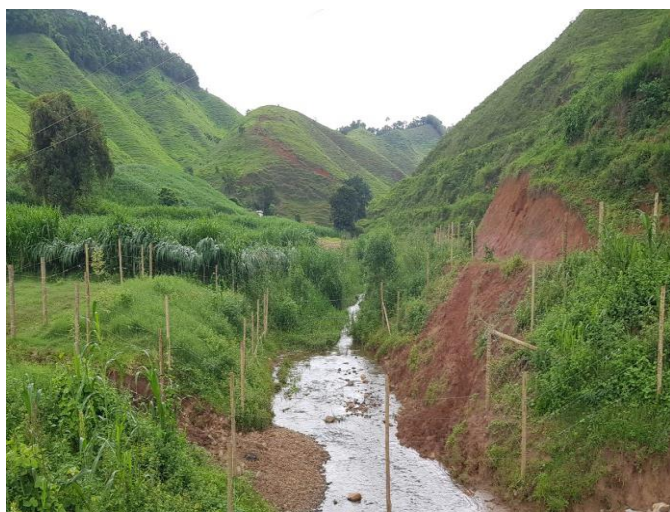
Imagem 319- Situação do TC06 após as obras, remoção dos rejeitos do leito e conformação de taludes, criação de passagem para animais.
