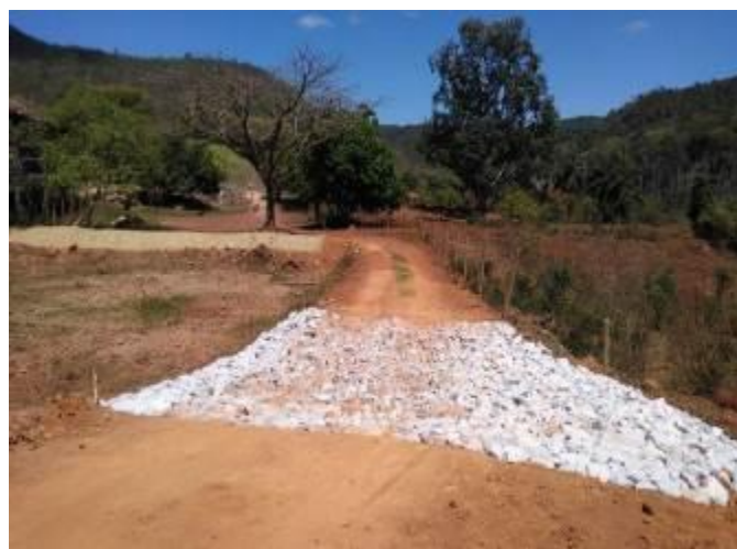
Imagem 402- Passagem molhada executada no TG17A/ITG19.
