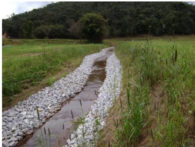
Imagem 92- Situação do TG29 após as obras de recuperação, tratamento do fundo do canal e taludes.
