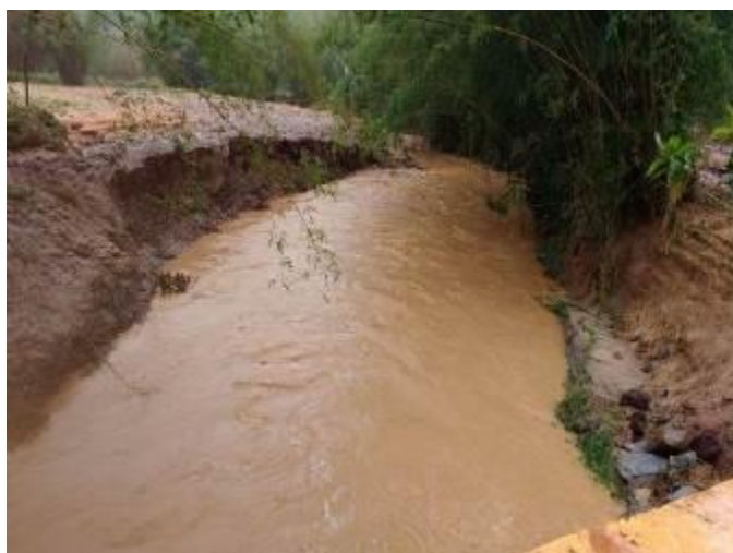
Imagem 428- Situação de trechos mais críticos do TC02 após as chuvas- Danos aos serviços de bioengenharia já executados.
