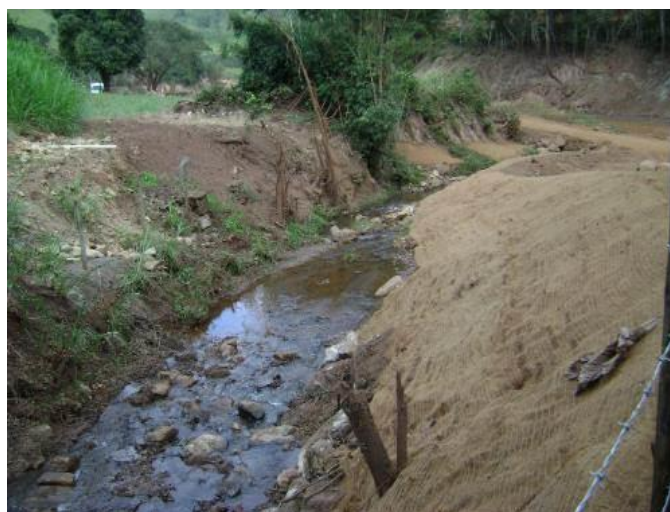
Imagem 134- Situação do TG26 após as obras, instalação de biomanta nos taludes e remoção dos rejeitos do leito.
