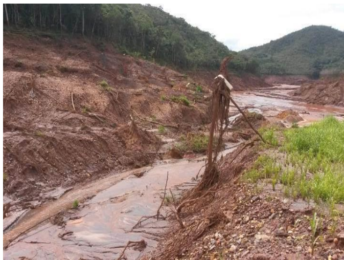
Imagem 239- Vista de montante para jusante do trecho de deságue. Escoamento sobre rejeitos e presença de ravinas nos taludes, situação em 03/03/2016.
