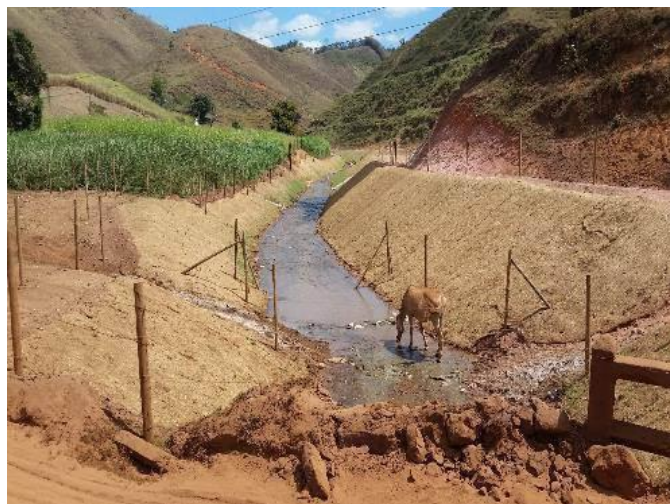
Imagem 318- Situação do TC06 após as obras, remoção dos rejeitos do leito e conformação de taludes, criação de passagem para animais.
