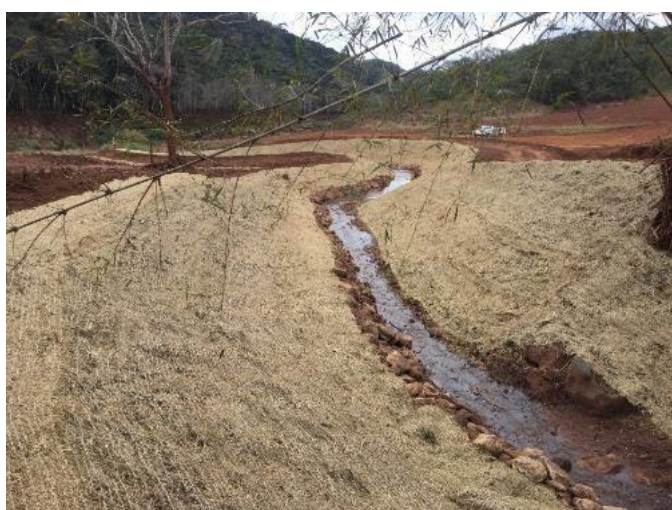
Imagem 63- Situação do TG22 durante as obras, remoção dos rejeitos do fundo do canal, conformação dos taludes e instalação de biomanta antierosiva.
