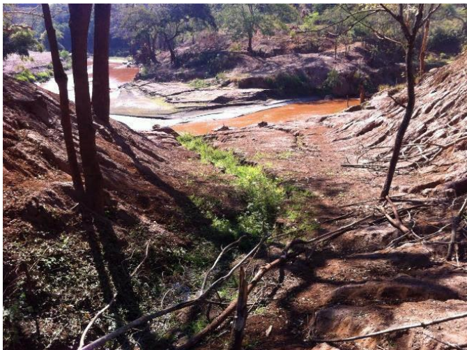
Imagem 333- Vista de montante para jusante do trecho de deságue antes das intervenções, presença de ravinas nos taludes, tributário de pequeno porte, baixa vazão.
