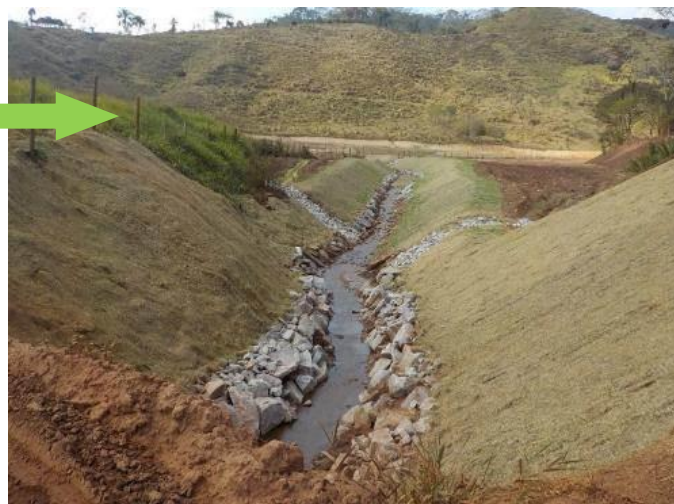
Imagem 54- Foto do mesmo local quando a obra já estava finalizada, em 22/08/2016, tratamento de leito e taludes.
