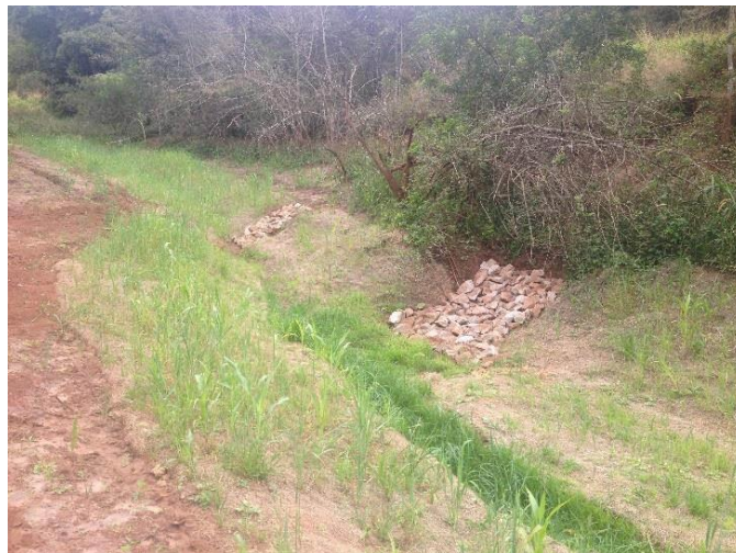
Imagem 110- Situação do TG42 após as obras de recuperação, tratamento dos taludes e execução de dispositivos de drenagem superficial.
