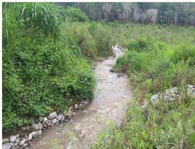
Imagem 196- Situação do TG11 após as obras de recuperação, aplicação de enrocamento na seção de escoamento.
