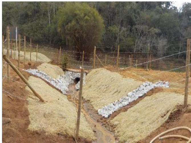
Imagem 326- Situação do TG43 após as obras, remoção dos rejeitos do fundo, conformação de taludes e execução de dispositivos de drenagem.
