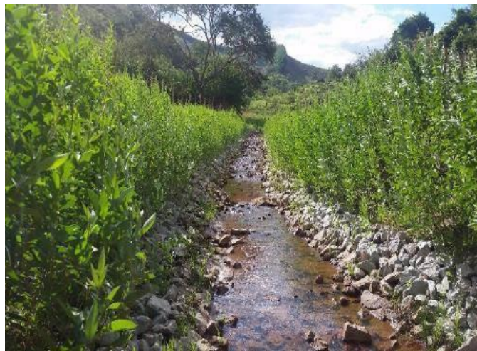
Imagem 350- Situação do TG56 após as obras de recuperação, tratamento do leito e crescimento da vegetação.
