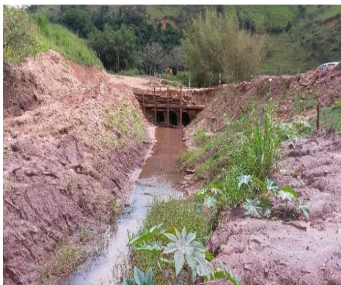
Imagem 205- Situação do TC03 antes das obras, necessidade de remoção dos rejeitos do leito e margens.
