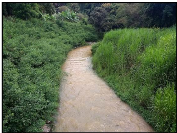
Imagem 267 Situação do TG49A após as obras de recuperação ambiental. Margens revegetadas e base estabilizada por enrocamento.
