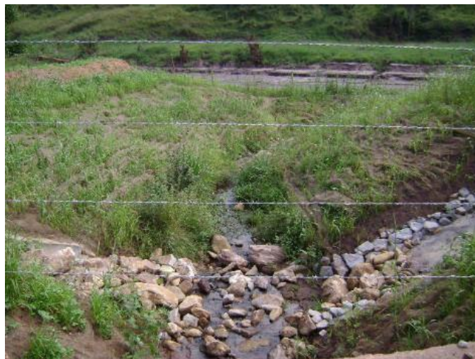
Imagem 138- Situação do TG27 após as obras, execução de dispositivos de drenagem e crescimento da vegetação.
