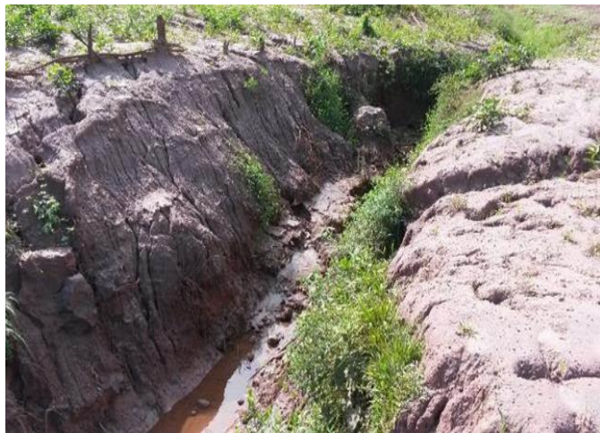
Imagem 57- Situação do TC01 antes das intervenções, ravinas e erosões nos taludes e margens.
