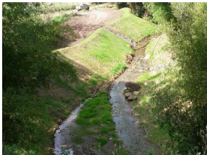
Imagem 342- Situação do tributário TG51 após as obras de recuperação ambiental, crescimento da vegetação nos taludes e execução de dispositivos de drenagem superficial.
