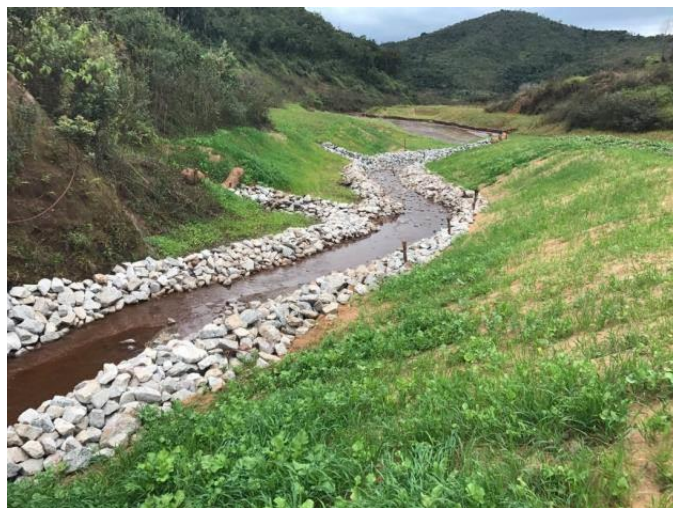
Imagem 240- Situação do TG06 após as obras de recuperação, Visão da área à montante. Sistemas de drenagens com saídas d'água.
