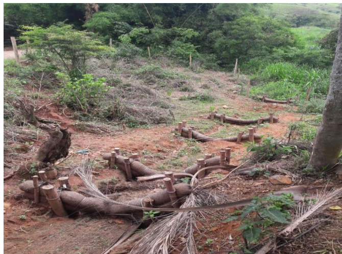
Imagem 224- Situação do TD02 após as obras de recuperação. Aplicação de retentores de sedimentos e revegetação.
