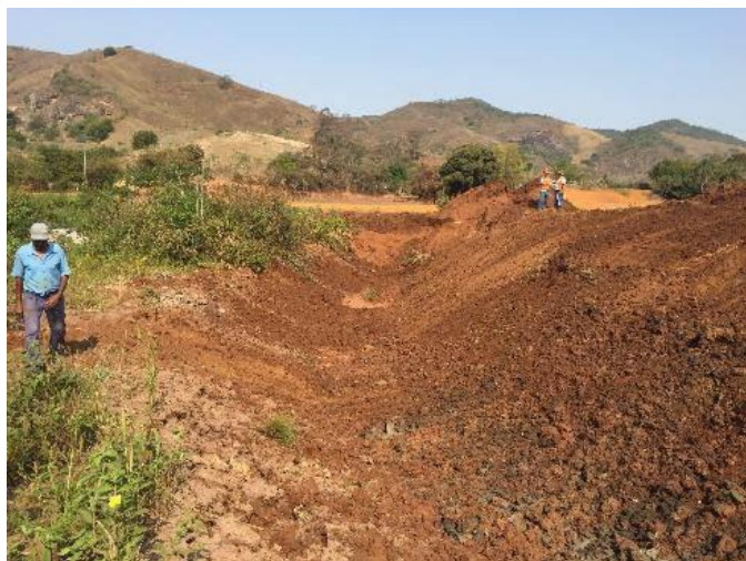
Imagem 121- Abertura do canal, trecho do desvio, trabalho a seco. TG39 durante a execução da obra.
