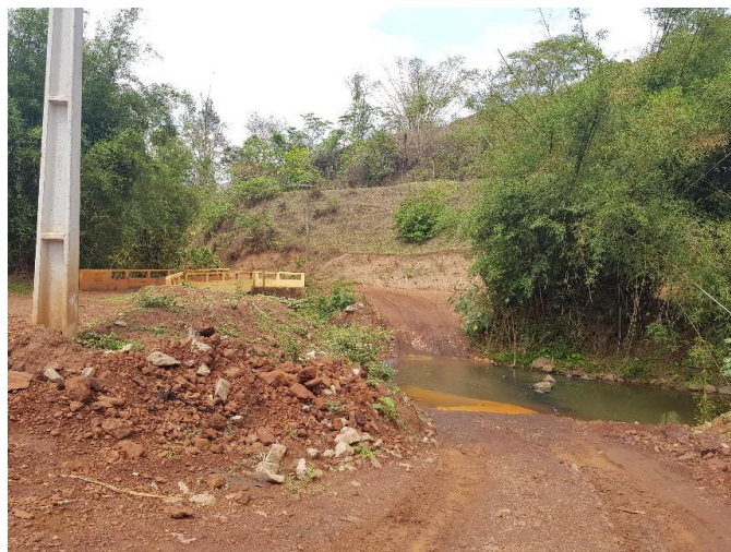
Imagem 431- Passagem molhada realizada devido a problemas estruturais na ponte, após reconstrução da mesma a passagem será removida e a área recuperada.
