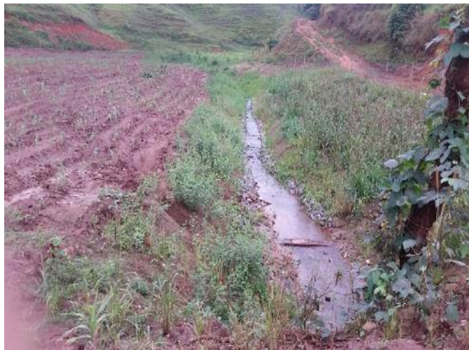
Imagem 337- Vista do trecho 1 do TG50 antes das obras de recuperação, fluxo d'água erodindo a lateral do canal.
