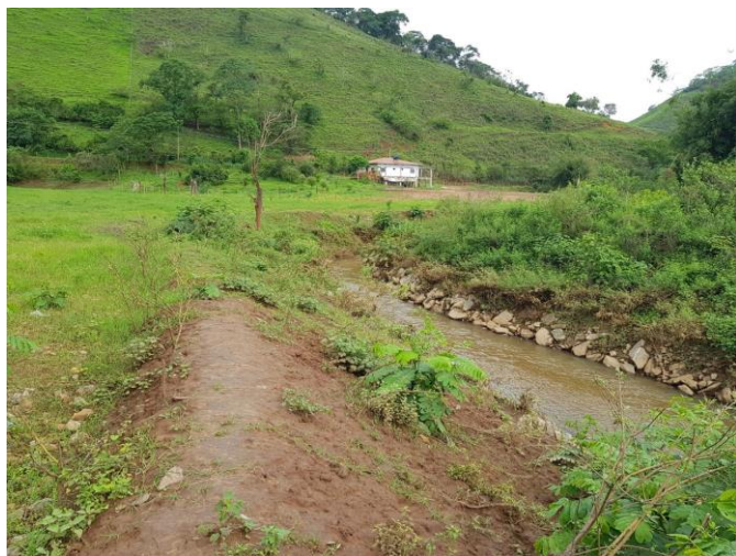
Imagem 430- Trecho do TC02 que necessita de intervenção: execução de enrocamento, aplicação de biomanta e sementeira.
