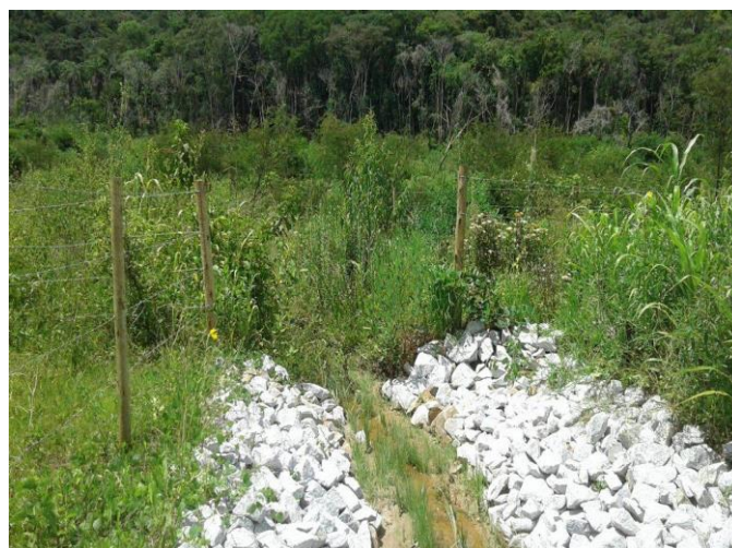
Imagem 453- Obras de bioengenharia executadas no tributário TG17E: Drenagem de planícies com aplicação de enrocamentos.
