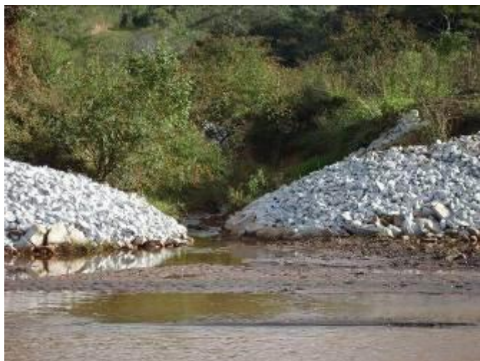
Imagem 411- Foz do tributário TG15 – Trecho 2, mostrando proteção das margens e sistema de drenagem.
