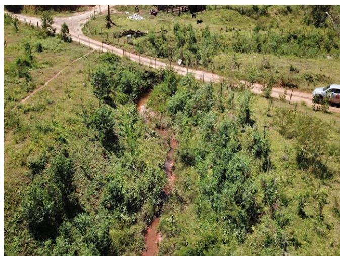
Imagem 156- Vista da mesma região após as obras, execução de dispositivos de drenagem superficial e proteção da seção de escoamento com enrocamento.
