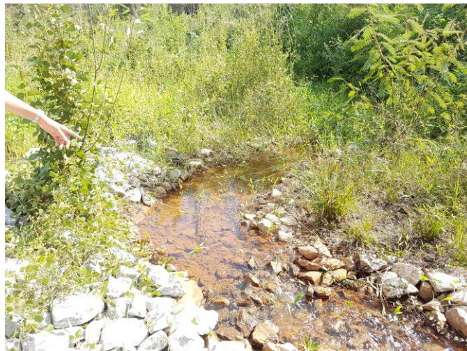
Imagem 10- Margens conformadas, aplicada proteção com enrocamento, vegetação restabelecida.
