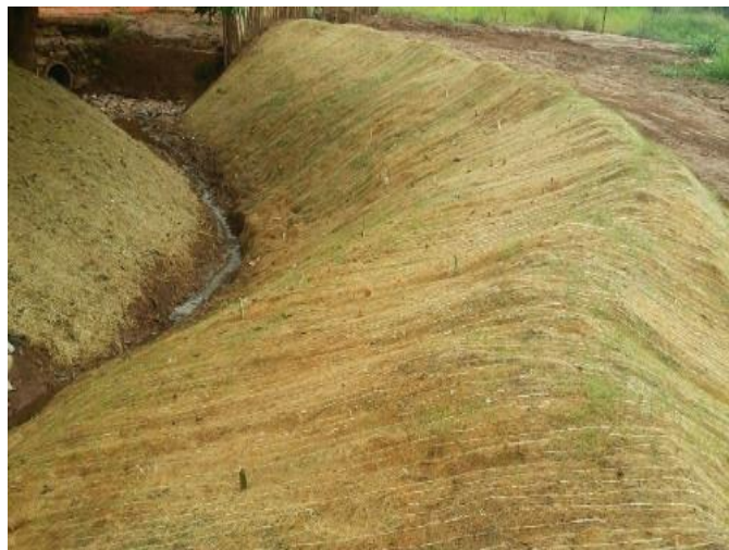
Imagem 220- Situação do TC10 após as obras, remoção dos rejeitos do leito e aplicação de biomanta antierosiva nos taludes.
