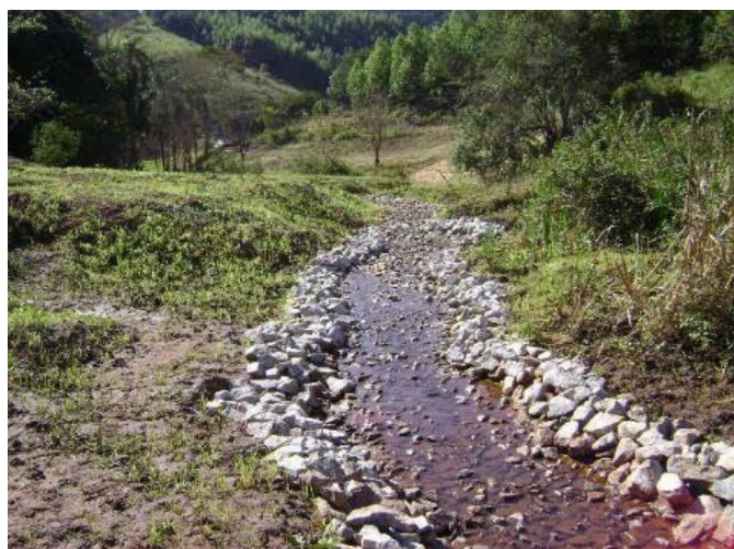
Imagem 128- Situação do TG25 após as obras de recuperação, tratamento do fundo e laterais.
