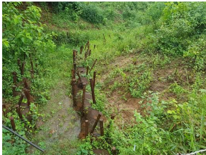
Imagem 322- Situação do TC04 durante as obras de recuperação: Revegetação e aplicação de retentores de sedimentos.
