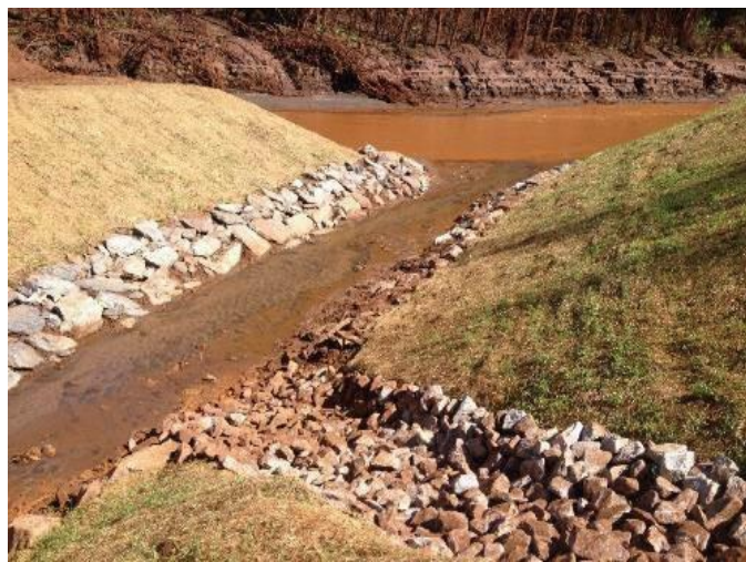
Imagem 118- Situação do TG39 após as obras, tratamento de leito e taludes.
