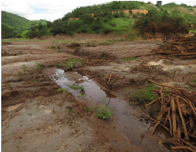
Imagem 183- Vista de montante para jusante do TG19, escoamento sobre rejeitos e presença de galhadas na planície antes das obras de recuperação.
