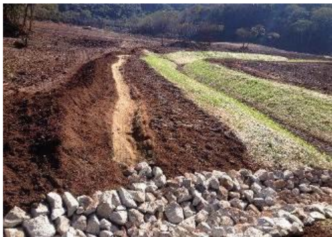
Imagem 391- Situação do TG35 logo após as obras de recuperação. Remoção dos rejeitos do leito, conformação dos taludes e instalação de biomanta.
