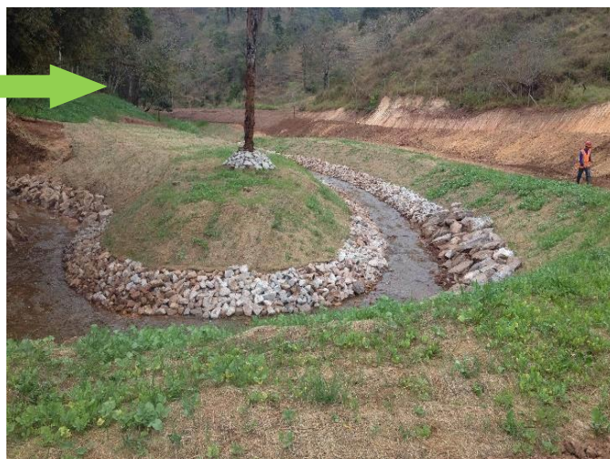
Imagem 48- Vista do mesmo local após as obras de remoção dos rejeitos, conformação dos taludes, revegetação.
