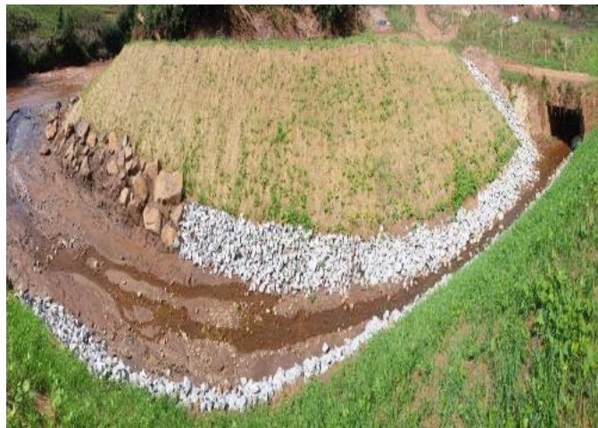
Imagem 68- Situação do tributário 52 após as obras de recuperação ambiental, conformação dos taludes e instalação de biomantas antierosivas.
