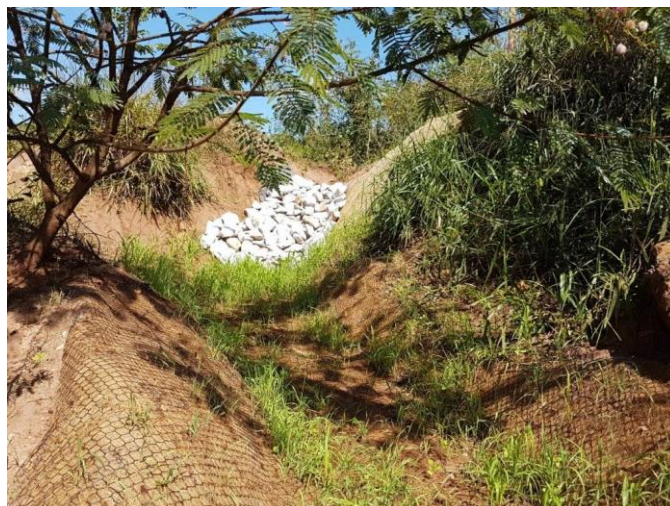
Imagem 412- Tributário TG15, margens com execução de bioengenharia (biomantas, sementeira e drenagens).
