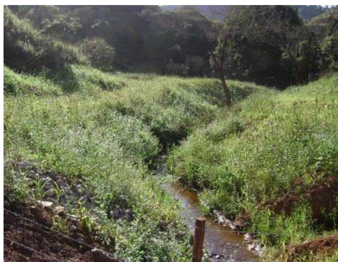
Imagem 140- Situação do TG27 após as obras de recuperação, ravinas estabilizadas após o plantio.
