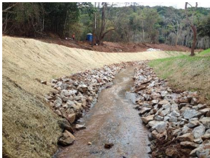
Imagem 116- Vista da seção de escoamento de montante para jusante no trecho 2 do TG39, após as obras de enrocamento do pé dos taludes a fim de evitar erosões.
