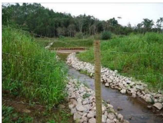
Imagem 408- Foz e margens conformadas e aplicadas biomantas e proteção de pé com enrocamento- TG17B/ ITG21.
