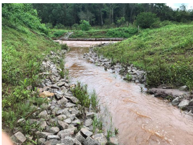
Imagem 407- Foz e margens conformadas e aplicadas biomantas e proteção de pé com enrocamento- TG17B/ ITG21.
