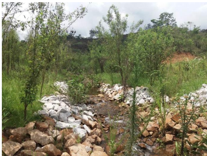
Imagem 19- Margens conformadas, aplicada proteção com enrocamento, vegetação restabelecida.
