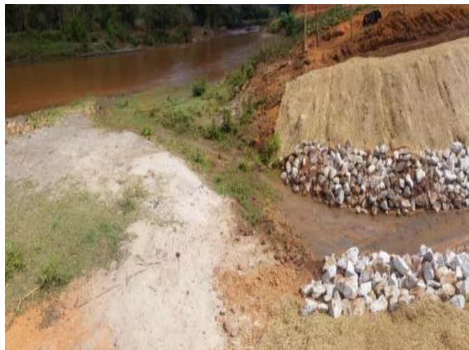
Imagem 366- Situação do TC09 após as obras de recuperação, instalação de biomanta antierosiva e aplicação de enrocamento na seção de escoamento.
