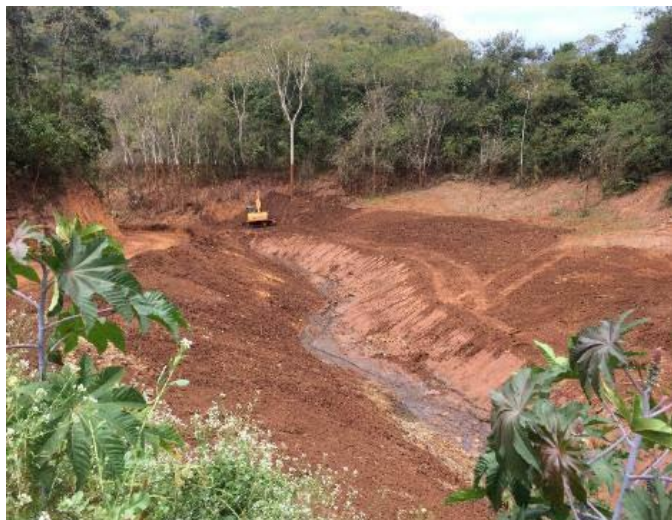
Imagem 199- Visão geral do TG13 durante as obras, remoção dos rejeitos do fundo e conformação dos taludes.
