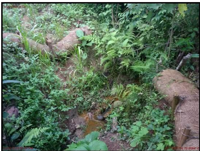
Imagem 335- Serviços de bioengenharia executados no Tributário TG54A: aplicação de retentores de sedimentos.
