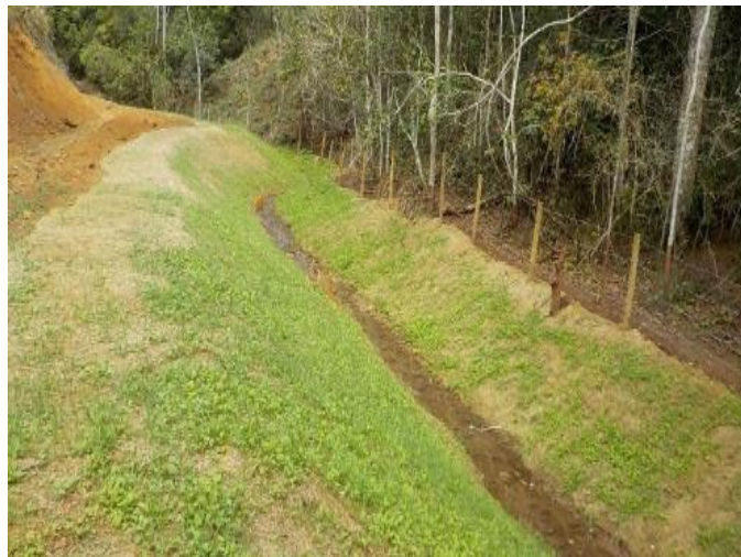
Imagem 104- Situação do TG41 após as obras de recuperação, instalação de biomanta e plantio nos taludes.
