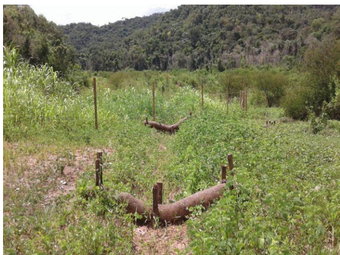
Imagem 452- Obras de bioengenharia executadas no tributário TG17E: Drenagem de planícies com aplicação de retentores de sedimentos.
